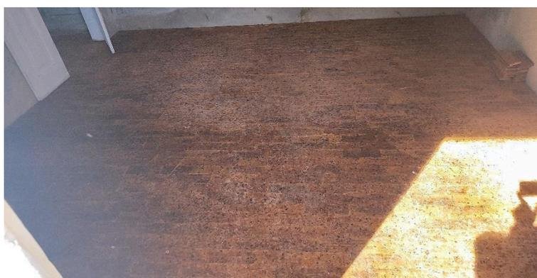
Presença de morcegos no interior da edificação – sujidades nas alvenarias e danos nos pisos de madeira
